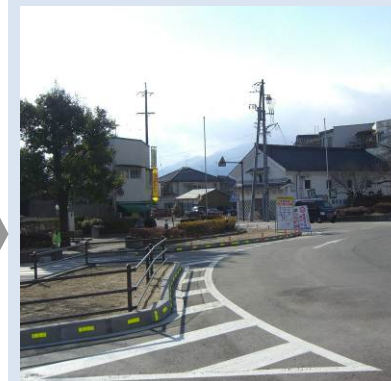
吾妻町ラウンドアバウトの交差点改良 : H22 社会実験により得られた知見をもとに、より安全な交差点を目指して交差点改良
